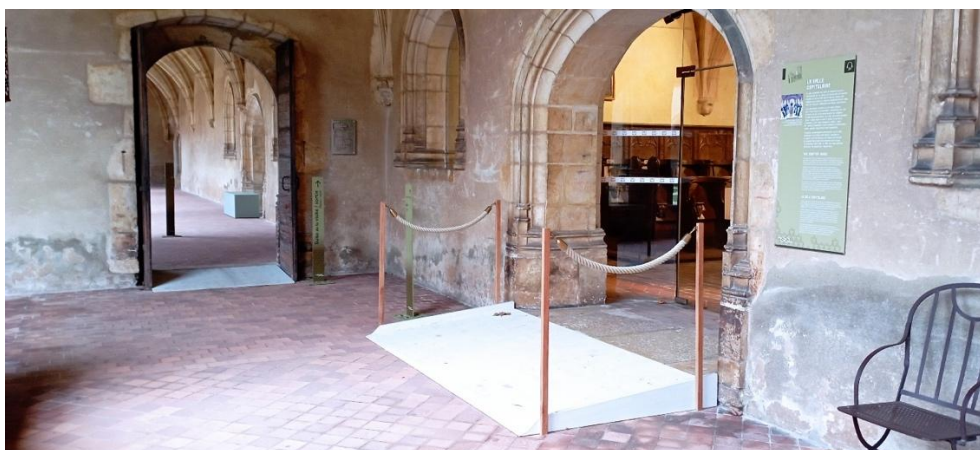
Rampe d'accès salle capitulaire.
