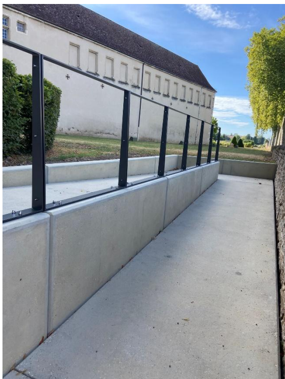
Rampe d'accès depuis le boulevard de Brou
