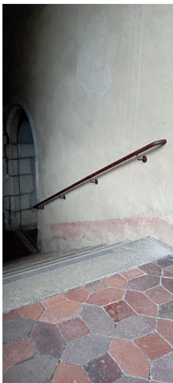
Main courante au premier étage du 3 e cloître à la sortie du musée
